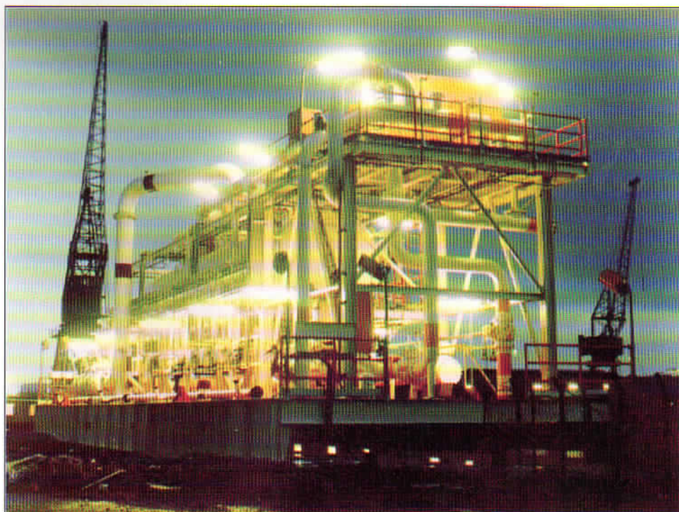
Instalação Industrial Petresco
