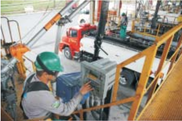
Carregamento automático do caminhão-tanque
