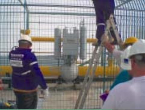
Atuador da Shafer em manutenção no Comgás
