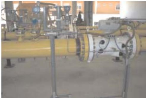
Skid de medição ultrassônica da Daniel instalado no CT-GAS
