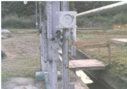
Detector de óleo em água da GE instalado no Tebig
