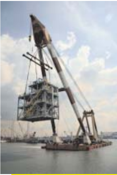
Operação do içamento do módulo (lift and go)
