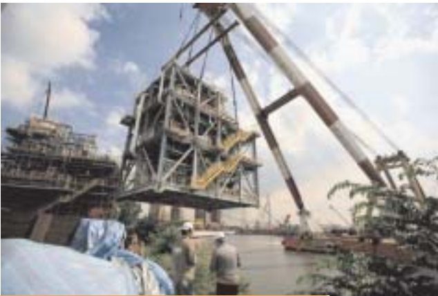
Operação de lifting de acoplamento ao módulo principal
