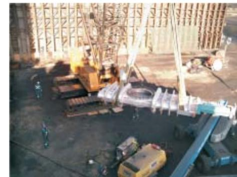
Válvula Deltaguard em içamento para instalação em tambor de coque
