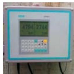
Medidor de vazão clamp-on FUS1010
