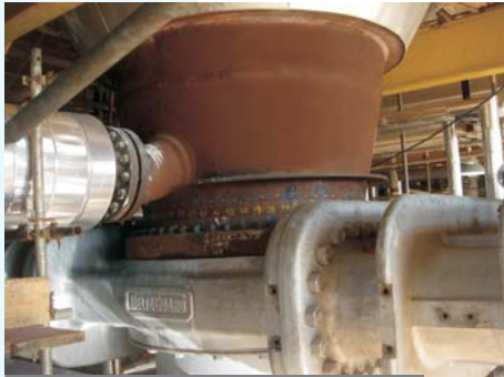
Válvula de fundo de tambor de coque DeltaValve
