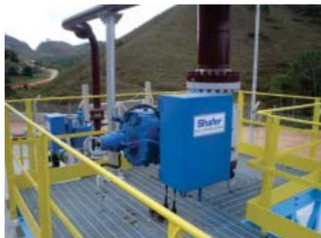
Valvula VTI instalada com atuador hidráulico da Shafer
