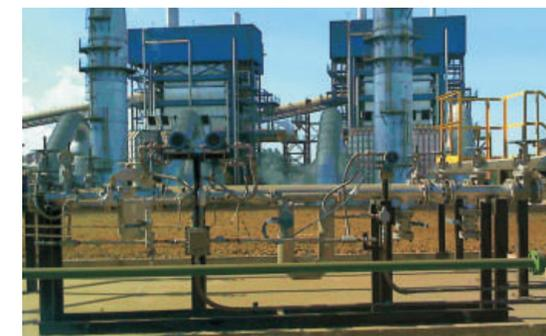
Sistema de medição de vazão e qualidade para controle de produção, similar ao adquirido pela a LDC-SEV
