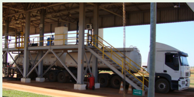
Skid de carregamento em funcionamento.
