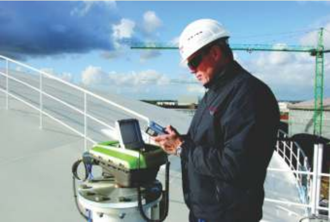
Monitoramento de tanque com medidor de nível Honeywell
