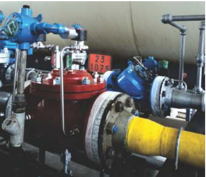
Segunda válvula OCV em operação no TABR
